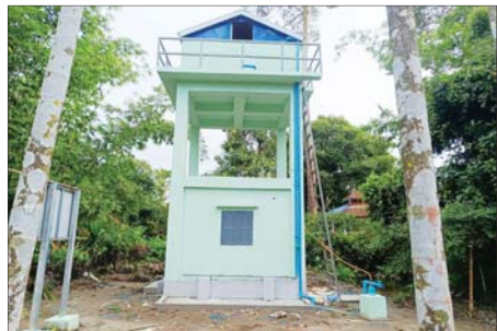
ညောင်တုန်းမြို့နယ်တွင် အယ်လ်နီညိုဖြစ်ပေါ်လာပါက ရေရှားပါး ပြတ်လပ်မှုမဖြစ်ပေါ်စေရေးအတွက် ၂၀၂၆-၂၀၂၇ ဘဏ္ဍာနှစ် ပြည်ထောင်စုစွန့်ပြန်ခံရမှုဖြင့် မြို့နယ်ကျေးလက်ဒေသဖွံ့ဖြိုး တိုးတက်ရေးဦးစီးဌာနက ဆောင်ရွက်နေသော ဝါးတောစွန်းကျေးရွာ အလျား၁၀ပေ၊ အနံ၁၀ပေ၊ အမြင့်၁၀ပေ၊ အမြင့်တင်ရေစင်(ရေစက်ရုံ) တည်ဆောက်ခြင်းလုပ်ငန်း ဆောင်ရွက်ပြီးစီးမှုကို အောက်တိုဘာ ၂၂ ရက်က တွေ့ရစဉ်။ တောစာလင်း
