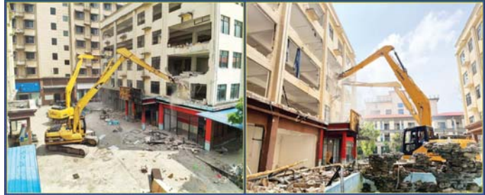
ရွှေကုက္ကိုလ်နယ်မြေ ဒုတိယပိုင်းအတွင်းရှိ အွန်လိုင်းလောင်းကစားမှုကျူးလွန်ရာတွင် အသုံးပြုခဲ့သည့် ၅ ထပ်အဆောက်အအုံအား စနစ်တကျဆက်လက်ဖြိုချ ဖျက်ဆီးလျက်ရှိမှုကို တွေ့ရစဉ်။
