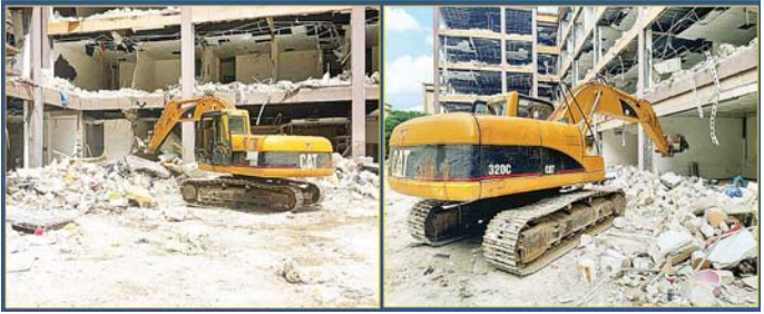
ရွှေကုက္ကိုလ်နယ်မြေ ဒုတိယပိုင်းအတွင်းရှိ အွန်လိုင်းလောင်းကစားမှုကျူးလွန်ရာတွင်အသုံးပြုသည့် တရားမဝင် ၅ ထပ် အဆောက်အအုံများအား ယန္တရားဖြင့် စနစ်တကျဖြိုချဖျက်ဆီးစဉ်။
