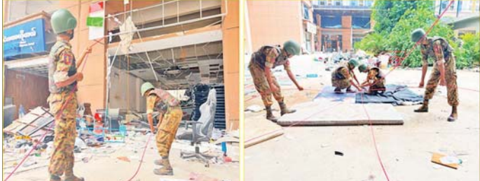
ရွှေကုက္ကိုလ်နယ်မြေ ဒုတိယပိုင်းအတွင်းရှိ အွန်လိုင်းလောင်းကစားမှု ကျူးလွန်ရာတွင် အသုံးပြုသည့် တရားမဝင် ခြောက်ထပ်အဆောက်အအုံအား စနစ်တကျဖြိုဖျက်ဆီးရန် ယမ်းကြိုးဆွဲခြင်း ဆောင်ရွက်မှု။
