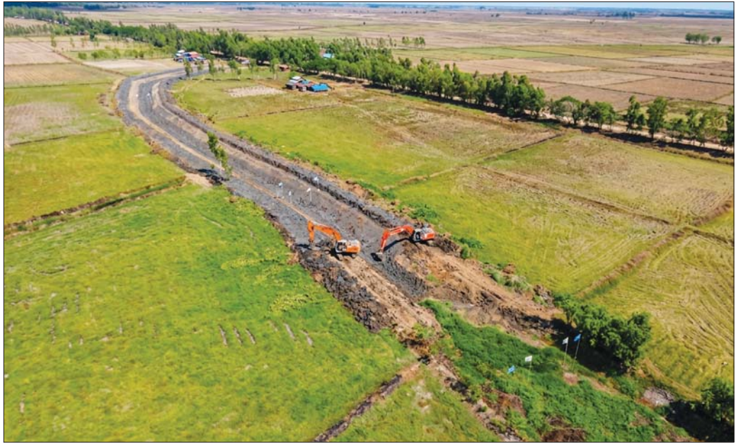
ဘိုကလေးမြို့နယ် မိုးညိုကျေးရွာအုပ်စု၌ ရေကြီးနစ်မြုပ်မှုကာကွယ်ရေးအတွက် စက်ယန္တရားများဖြင့် ရေချိုမြောင်း တူးဖော်နေမှုကို တွေ့ရစဉ်။
