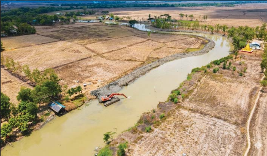
ဖျာပုံမြို့နယ် ဒေးဒလူကျေးရွာအုပ်စု၌ ရေကြီးမှုကာကွယ်ရေးအတွက် ဝါးချောင်းမြောင်းကို စက်ယန္တရားဖြင့် တူးဖော်နေမှုကို တွေ့ရစဉ်။
