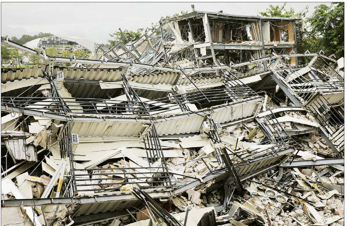
KK Park နယ်မြေအတွင်းရှိ အဆောက်အအုံများ ဖြိုချဖျက်ဆီးနေမှုကို တွေ့ရစဉ်။
