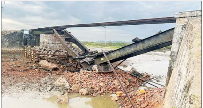
အကြမ်းဖက်သောင်းကျန်းသူအဖွဲ့၏ မိုင်းထောင်ဖောက်ခွဲမှုကြောင့် ပဲခူး-မော်လမြိုင်ရထားလမ်းပိုင်းအတွင်းရှိ နှင်းပုလဲနှင့် တောင်စွန်းဘူတာအကြား ရထားတံတားအမှတ်(၆၅) ထိခိုက်ပျက်စီးမှုအခြေအနေ။
