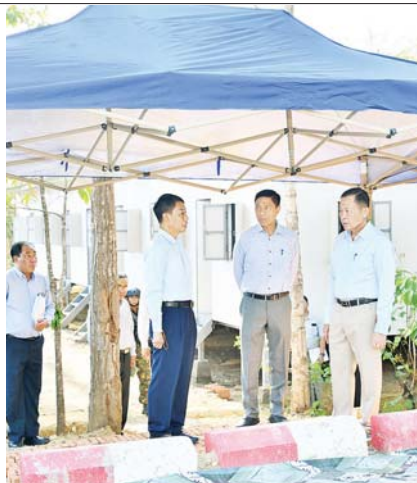
ဒုတိယဥက္ကဋ္ဌ ဒုတိယဝန်ကြီးချုပ်နှင့် အဖွဲ့ဝင်များသည် သပြေ(၂) အဆောင်(၅) အပျိုဆောင်နှင့် သပြေ(၄) အဆောင်(၈) လူပျိုဆောင်တို့တွင် လျှင်ဒဏ်ကြောင့် အနည်းငယ်ထိခိုက်ခဲ့သည့် နံရံများကို ဆောက်လုပ်ရေးဝန်ကြီးဌာနမှ ဝန်ထမ်းများက Sikalatex ဆေးရည်၊ ကျုံ့ခြင်းမရှိသော ဘိုလပ်မြေ
