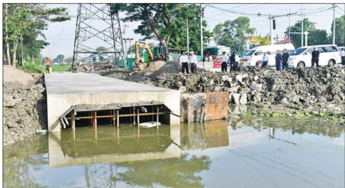
နှင့် တပင်ရွှေထီးလမ်းဆုံရှိ တပင်ရွှေထီးလမ်းဖြတ် (အလျား ၁၀ x အကျယ် ၁၂ x အနက် ၁၂) ပေ RC Box Culvert ဆောင်ရွက်နေမှုကို လည်းကောင်း၊
