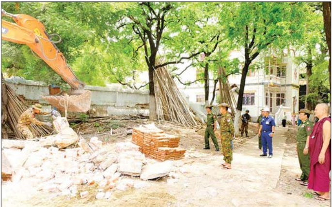
ကာကွယ်ရေးဦးစီးချုပ်ရုံး(ကြည်း)မှ ဒုတိယဗိုလ်ချုပ်ကြီး စိုးတင်နိုင် မန္တလေးမြို့ အမရပူရမြို့နယ်ရှိ ပုံပေါင်းကျောင်းတိုက်၌ အပျက်အစီးများ ဖယ်ရှားရှင်းလင်းဆောင်ရွက်နေမှုများ ကြည့်ရှုစစ်ဆေးစဉ်။
