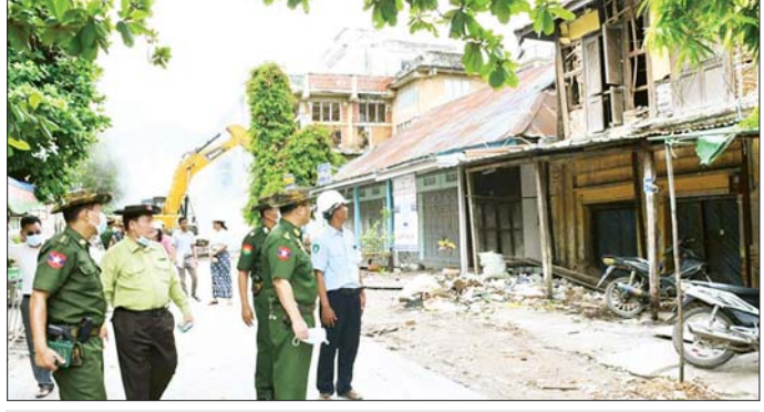
ကာကွယ်ရေးဦးစီးချုပ်ရုံး(ကြည်း)မှ ဒုတိယဗိုလ်ချုပ်ကြီး မျိုးသန့်နိုင် ကျောက်ဆည်မြို့ ဈေးတန်းရပ်ကွက်ရှိ နေထိုင်ရန်မသင့်သော အန္တရာယ်ရှိအဆောက်အအုံသုံးလုံး စက်ယန္တရားဖြင့် ရှင်းလင်းဆောင်ရွက်နေမှု ကြည့်ရှုစစ်ဆေးစဉ်။
