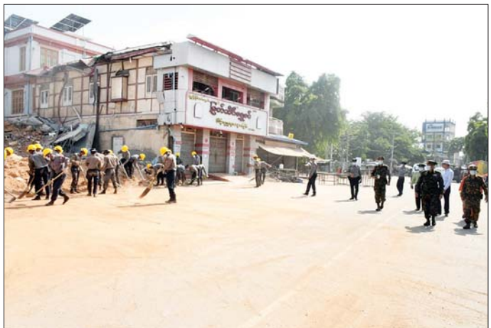
ကာကွယ်ရေးဦးစီးချုပ်ရုံး(ကြည်း)မှ ဒုတိယဗိုလ်ချုပ်ကြီး သက်ဝင်းမြို့၊ လူနေအဆောက်အအုံများအား သွားရောက်ကြည့်ရှုစစ်ဆေးစဉ်။
