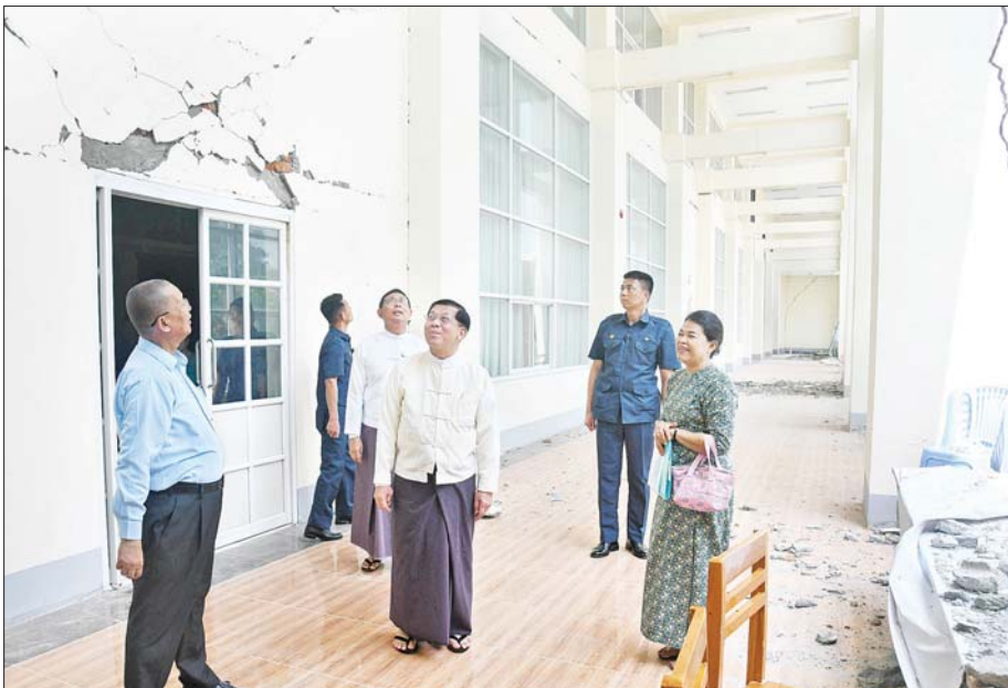
နိုင်ငံတော်စီမံအုပ်ချုပ်ရေးကောင်စီဥက္ကဋ္ဌ နိုင်ငံတော်ဝန်ကြီးချုပ် ဗိုလ်ချုပ်မှူးကြီး မင်းအောင်လှိုင် မန္တလေးငလျင်ကြီးကြောင့် အမျိုးသားစာကြည့် တိုက် (နေပြည်တော်) အဆောက်အအုံ ထိခိုက်ပျက်စီးမှုကို ကြည့်ရှုစစ်ဆေးစဉ်။
