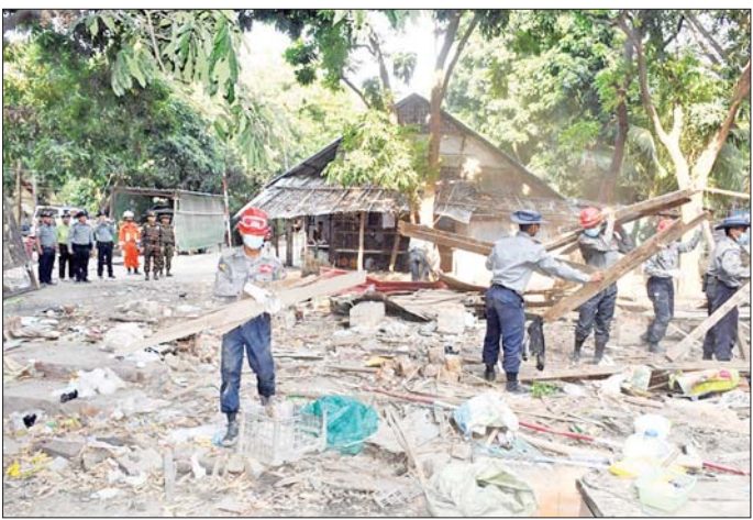
ကာကွယ်ရေးဦးစီးချုပ်ရုံး(ကြည်း)မှ ဒုတိယဗိုလ်ချုပ်ကြီး သက်ဝံနှင့် တာဝန်ရှိသူများ စစ်ကိုင်းမြို့၌ ငလျင်ဒဏ်ကြောင့် ပြိုကျပျက်စီးခဲ့သည့် လူနေအဆောက်အအုံနှင့် မြို့မရဲစခန်းအဆောက်အအုံ အပျက်အစီးများ ရှင်းလင်းဖယ်ရှားနေမှုကို ကြည့်ရှုစစ်ဆေးစဉ်။
