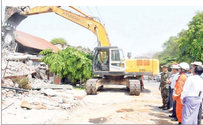
တိုင်းဒေသကြီးဝန်ကြီးချုပ် ဦးမြတ်ကျော်နှင့် ကာကွယ်ရေးဦးစီးချုပ်ရုံး(ကြည်း)မှ ဒုတိယဗိုလ်ချုပ်ကြီး သက်ဝဲတို့ စစ်ကိုင်းမြို့ရှိ လူနေအဆောက်အအုံအပျက်အစီးများ ဖယ်ရှားရှင်းလင်းနေမှုကို ကြည့်ရှု စစ်ဆေးစဉ်။
