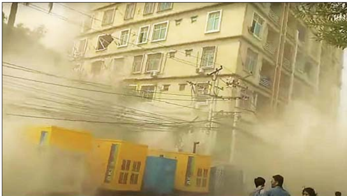
မန္တလေးမြို့တွင်ပင် မမှန်မကန်တည်ဆောက်ခဲ့သော အဆောက်အအုံနှင့် ကျွမ်းကျင်ပညာရှင်များနှင့် မှန်ကန်စွာ ဆောက်လုပ်ခဲ့သောကြောင့် မပျက်မစီး တည်မြဲခဲ့သော အဆောက်အအုံတို့ နှိုင်းယှဉ်ပြပုံ။ (ဤပုံတို့သည် ၂၀၂၅ ခုနှစ် မတ်လ ၂၈ ရက်နေ့နောက်ပိုင်း ရိုက်ကူးထားသော ဓာတ်ပုံများဖြစ်သည်။)
