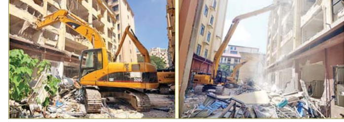
ရွှေကုက္ကိုလ်နယ်မြေ ဒုတိယပိုင်းအတွင်းရှိ အွန်လိုင်းလောင်းကစားမှုကျူးလွန်ရာတွင် အသုံးပြုခဲ့သည့် ၅ ထပ် အဆောက်အအုံအား စနစ်တကျဆက်လက်ဖြိုချဖျက်ဆီးမှု
