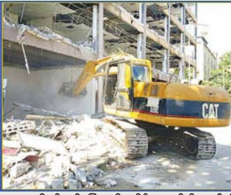
ရွှေကုက္ကိုလ်နယ်မြေ ဒုတိယပိုင်းအတွင်းရှိ အွန်လိုင်းလောင်းကစားမှုကျူးလွန်ရာတွင် အသုံးပြုသည့် တရားမဝင် ၅ တပ်အဆောက်အအုံများအား ယန္တရားဖြင့် စနစ်တကျဖြိုချဖျက်ဆီးလျက်ရှိမှု။
