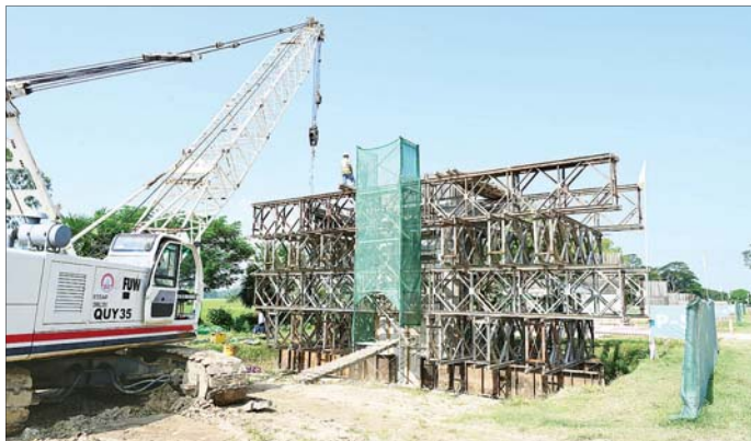
နေပြည်တော် - တောင်တွင်းကြီး မီးရထားလမ်းခုံးကျော်တံတား တည်ဆောက်ရေးလုပ်ငန်းခွင်ကို တွေ့ရစဉ်။
