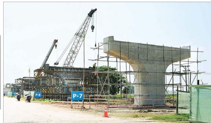
ရန်ကုန် - မန္တလေး မီးရထားလမ်းခုံးကျော်တံတား တည်ဆောက်ရေးလုပ်ငန်းခွင်ကို တွေ့ရစဉ်။
