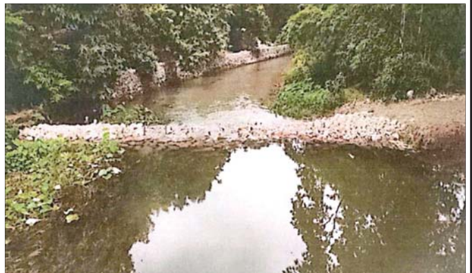
ပေါင်ဖြူနယ် ကရင်စုကျေးရွာ၌ Cash For Work စီမံကိန်းဖြင့် ဆောင်ရွက်ခဲ့သည့် Check Dam ကို တွေ့ရစဉ်။
