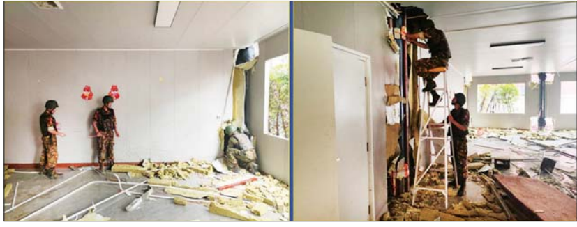
ကရင်ပြည်နယ် မြဝတီခရိုင် ရွှေကုက္ကိုလ်နယ်မြေရှိ အွန်လိုင်းလိမ်လည်လောင်းကစားမှုလုပ်ကိုင်ခဲ့သည့် တရားမဝင် ခုနစ်ထပ်လူနေအဆောက်အအုံအား ယမ်းဖြင့်ဖောက်ခွဲဖျက်ဆီးရန် ပြင်ဆင်နေစဉ်။
