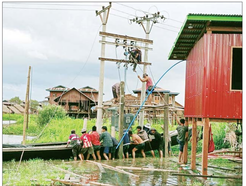
အင်းလေးဒေသအတွင်း လျှပ်စစ်ဓာတ်အားလိုင်းများ ပြန်လည်ပြင်ဆင်ဆောင်ရွက်နေမှုကို တွေ့ရစဉ်။
