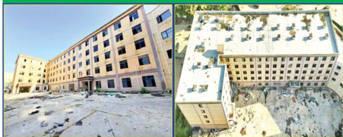
ကရင်ပြည်နယ်၊ မြဝတီခရိုင်၊ ရွှေကုက္ကိုလ်နယ်မြေ၌ အွန်လိုင်းလောင်းကစားလုပ်ငန်းလုပ်ကိုင်ခဲ့သော တရားမဝင်အဆောက်အအုံအား ဖြိုချဖျက်ဆီးမှု
