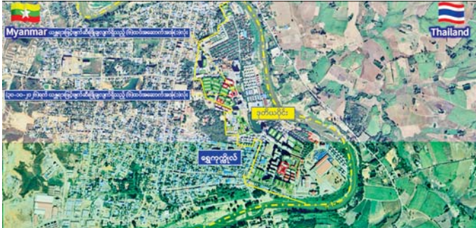
ရွှေကုက္ကိုလ်နယ်မြေ ဒုတိယပိုင်းအတွင်းရှိ အွန်လိုင်းလောင်းကစားမှုကျူးလွန်ရာတွင် အသုံးပြုသည့် တရားမဝင်အဆောက်အအုံများအား စနစ်တကျဆက်လက်ဖြိုချဖျက်ဆီးမှု။
