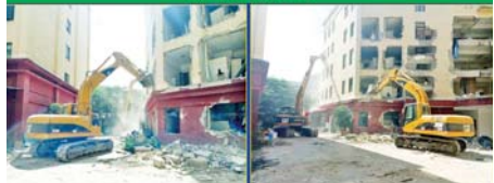
ရွှေကုက္ကိုလ်နယ်မြေ ဒုတိယပိုင်းအတွင်းရှိ အွန်လိုင်းလောင်းကစားမှု ကျူးလွန်ရာတွင် အသုံးပြုခဲ့သည့် (၆) ထပ် အဆောက်အအုံအား စနစ်တကျဆက်လက်ဖြိုချဖျက်ဆီးမှု
