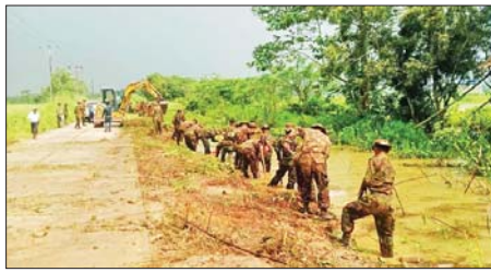
လှည်းကူးမြို့နယ် ဆီဆုံကုန်းကျေးရွာ လမ်းဘေးဝဲယာတစ်လျှောက် ရေစီးရေလာကောင်းမွန်စေရေး ဆောင်ရွက်စဉ်။
