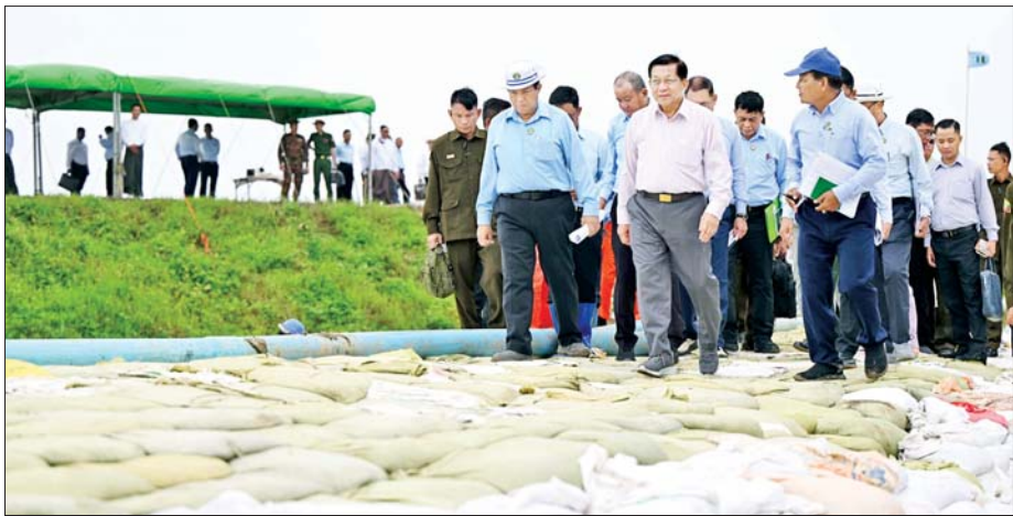
နိုင်ငံတော်သမ္မတ ဦးမင်းအောင်လှိုင် ဧရာဝတီတိုင်းဒေသကြီး ညောင်တုန်းမြို့နယ် ဂန်ချောင်းကျေးရွာအနီး ညောင်တုန်းကျွန်းတာ (ဧရာဝတီမြစ်ခွဲ) တာကိုယ်ထည်ရေတိုက်စားခံရမှု တားဆီးကာကွယ်ရေးလုပ်ငန်းများ ဆောင်ရွက်နေမှုကို ကြည့်ရှုစစ်ဆေးစဉ်။
