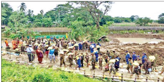
ပန်းတာ တည်ဆောက်ခြင်း၊ ကမ်းရင်းတာ (Bund Slope) တည်ဆောက်ခြင်းနှင့် ယာယီ ပန်းတာ၏ မြစ်ဘက် Slope အခြေထောက်ခြင်း လုပ်ငန်း များကို နယ်မြေခံတပ်မတော် သားများ၊ မြန်မာနိုင်ငံရဲတပ်ဖွဲ့ ဝင်များ၊ လူမှုရေးအသင်းအဖွဲ့များ နှင့် ဒေသခံပြည်သူများ ပူးပေါင်း ၍ စက်ယန္တရားများဖြင့် အင်တိုက် အားတိုက် အရှိန်အဟုန်ဖြင့် ဆက်လက်ဆောင်ရွက်လျက်ရှိ သည်။ ထိုသို့ ဆောင်ရွက်နေမှုများကို ရန်ကုန်တိုင်းစစ်ဌာနချုပ်မှ တာဝန် ရှိသူများနှင့် ဌာနဆိုင်ရာတာဝန် ရှိသူများက သွားရောက်ကြည့်ရှု စစ်ဆေးပြီး လိုအပ်သည်များ ပေါင်းစပ်ညှိနှိုင်း ဆောင်ရွက် ပေးခဲ့ကြောင်း သိရသည်။ သတင်းစဉ်
