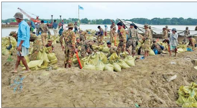
ဆက်လက်ဆောင်ရွက်လျက်ရှိသည်။ အဆိုပါ ကူညီကယ်ဆယ်ရေးနှင့် ရေဝင်ရောက်မှု တားဆီးကာကွယ်ရေးလုပ်ငန်း ဆောင်ရွက်နေမှု များကို အနောက်တောင်တိုင်းစစ်ဌာနချုပ်မှ တာဝန်ရှိသူများက သွားရောက်ကြည့်ရှုပြီး လိုအပ်သည်များ ပေါင်းစပ်ညှိနှိုင်းဆောင်ရွက်ပေး လျက်ရှိကြောင်း သိရသည်။ သတင်းစဉ်
