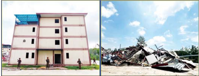
ကရင်ပြည်နယ် မြဝတီခရိုင် ရွှေကုက္ကိုလ်ဒေသ၌ တရားမဝင်အဆောက်အအုံများအား မဖြိုဖျက်မီနှင့် မဖြိုဖျက်ပြီးနောက် တွေ့ရစဉ်။
