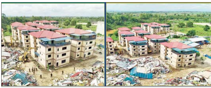
ကရင်ပြည်နယ် မြဝတီမြို့နယ် ရွှေကုက္ကိုလ်ဒေသ၌ အွန်လိုင်းလိမ်လည်လောင်းကစားလုပ်ငန်း လုပ်ကိုင်ခဲ့သော အဆောက်အအုံများကို မဖြိုဖျက်မီနှင့် ဖြိုဖျက်ပြီးနောက် တွေ့ရစဉ်။
