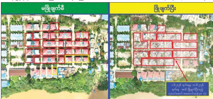
ရွှေကုက္ကိုလ်နယ်မြေ၌ အွန်လိုင်းလောင်းကစားလုပ်ငန်း လုပ်ကိုင်ခဲ့သော တရားမဝင် အဆောက်အအုံ များအား ယန္တရားများဖြင့် ဖြိုချဖျက်ဆီးမှုကို တွေ့ရစဉ်။
