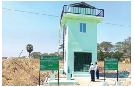
တိုက်ကြီးမြို့နယ်၌ ရေသန့်စင်စနစ် တည်ဆောက်ခြင်းနှင့် မြေသားရေကန်အနက်နှိုက်ခြင်းလုပ်ငန်းဆောင်ရွက်
