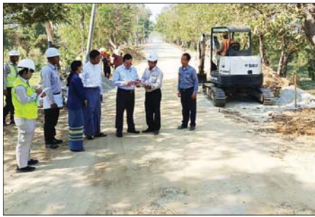
ကျောက်ကတ္တရာထပ်ပိုးလွှာခင်းခြင်းလုပ်ငန်းနှင့် တံတားပြုပြင်ခြင်း လုပ်ငန်းဆောင်ရွက်နေမှုများကို ကြည့်ရှုစစ်ဆေးကာ အရည်အသွေး ပြည့်မီရေး မှာကြားသည်။
