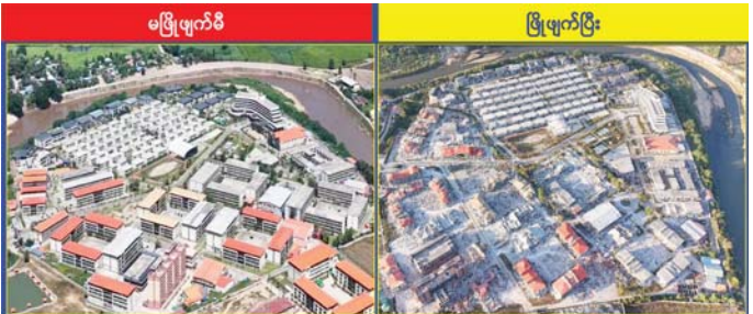
KK Park နယ်မြေအပိုင်း(၁)အား ဖောက်ခွဲဖျက်ဆီး ဖြိုချထားရှိမှုကို တွေ့ရစဉ်။
