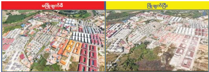
KK Park နယ်မြေအပိုင်း(၃)အား ဖောက်ခွဲဖျက်ဆီး ဖြိုချထားရှိမှုကို တွေ့ရစဉ်။
