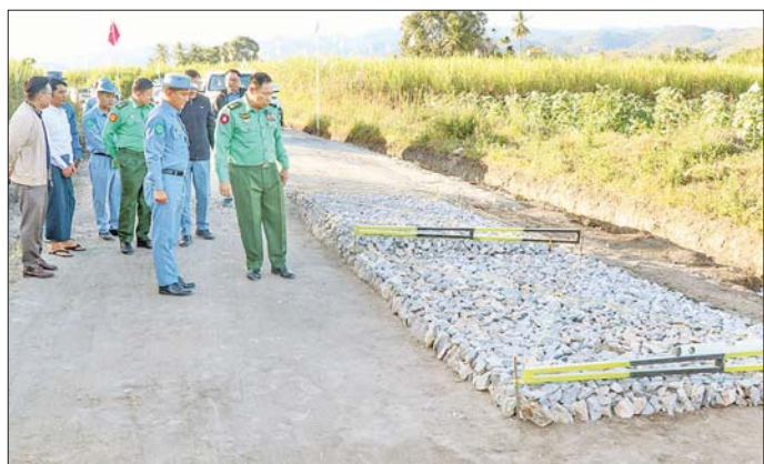
ယင်းနောက် မိုးနဲ- ကင်တုံ- လုံစံ ကျေးရွာချင်း ကျောက်စီမြေထိန်းနံရံ ဆောင်ရွက်ထားရှိမှုအခြေ ဆက်လမ်းတွင် ၃၀ x ၁၄ ပေ ကွန်ကရစ် တံတား အနေများကို ကြည့်ရှုစစ်ဆေးပြီး လိုအပ်သည်များ တစ်စင်းတည်ဆောက်နေမှု၊ ချဉ်းကပ်လမ်းနှင့် မှာကြားခဲ့ကြောင်း သတင်းရရှိသည်။ သတင်းစဉ်
