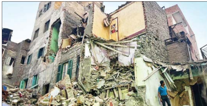
ပြိုကျနေသည့် အပျက်အစီးများအောက် ကယ်ဆယ်ရေးလုပ်ငန်းများ ဆောင်ရွက်နေသည်ကို ဒီဇင်ဘာ ၂၅ ရက်က တွေ့ရစဉ်။
