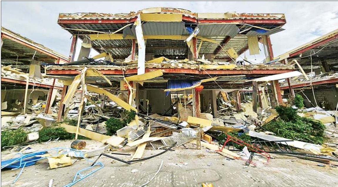
KK Park နယ်မြေအတွင်း၌ အွန်လိုင်းလိမ်လည် လောင်းကစားမှုများကျူးလွန်ရာတွင် အသုံးပြုသည့်အဆောက်အအုံများအား စနစ်တကျဖောက်ခွဲဖျက်ဆီးပြီး တွေ့ရစဉ်။
