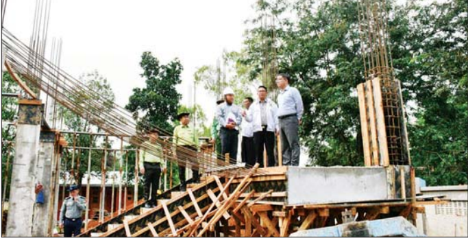
သံကွက်ကရစ် အဆောက်အအုံတည်ဆောက်နေမှုကို ကြည့်ရှုစစ်ဆေးကာ လုပ်ငန်းများ သတ်မှတ်အရည်အသွေး ပြည့်မီစွာဖြင့် ရှိသူများအား မှာကြားခဲ့ကြောင်း သတိပေးသည်။
