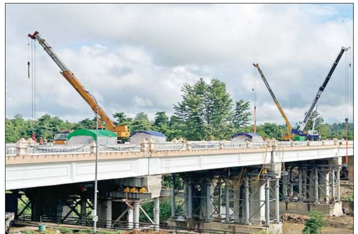
ငလျင်ဒဏ်ကြောင့် ထိခိုက်ပျက်စီးခဲ့သည့် လွှတ်တော်အဝင် အမှတ် (၁) တံတားအား ခေတ်မီနည်းပညာ များဖြင့် ပြုပြင်ဆောင်ရွက်နေမှုကို တွေ့ရစဉ်။
