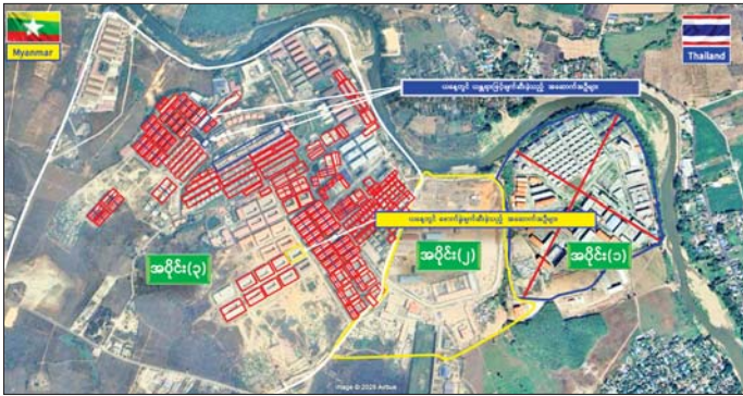
ကရင်ပြည်နယ် မြဝတီမြို့နယ်အတွင်းရှိ KK Park နယ်မြေအပိုင်း (၃)မှ အဆောက်အအုံများအား ဖျက်ဆီးထားရှိမှုကို တွေ့ရစဉ်။
